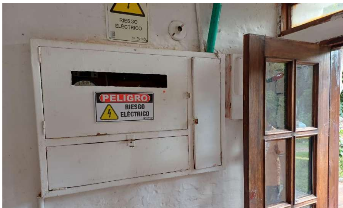
DESPUÉS: GABINETE MODERNO CON TABLEROS DE DISTRIBUCIÓN PARCIALES QUE ORGANIZAN LOS CIRCUITOS.
